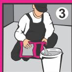
**3** Для подготовки раствора залейте водопроводную воду комнатной температуры в чистую ёмкость из расчёта 8,8 - 9,6 л воды на 1 мешок (20 кг).
